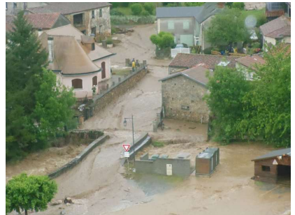
Le Bas-Nistos occupé par les eaux de l'Arize et du Nistos en 2011 (photo : Mairie)
