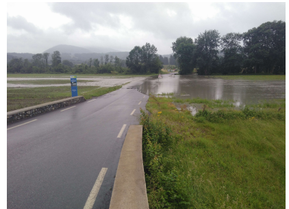
La D75 en direction de Nestier sous les eaux de la Neste.
