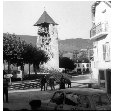
Le clocher de l'église d'Arette (64) après le séisme de 1967 (Archives de la Mairie d'Arette).
