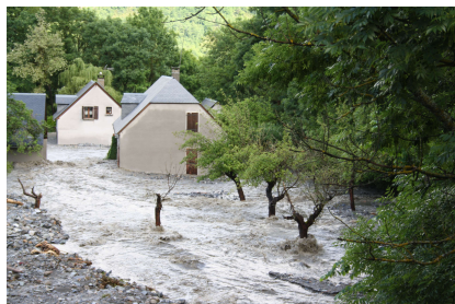
Quartier d'habitations sous les eaux (photo : Mairie)
