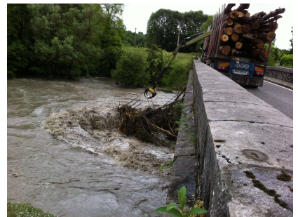
Le pont de la D71 en 2013 (photo : Mairie)
