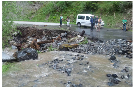
La route vers les granges de Lurgues, impactée par la crue du Lavedan.
