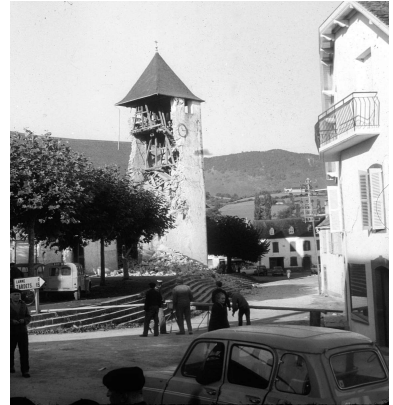
Le clocher de l'église d'Arette (64) après le séisme de 1967 (Archives de la Mairie d'Arette)
