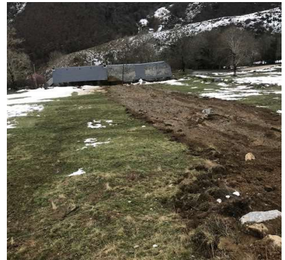
Un glissement de terre a fini sa course contre une grange située en aval à Aspin-Aure (photo : mairie)
