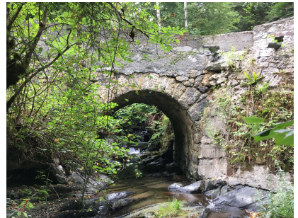
Le ruisseau d'Ardengost passant sous le pont de la D19 (Photo : C-PRIM)
