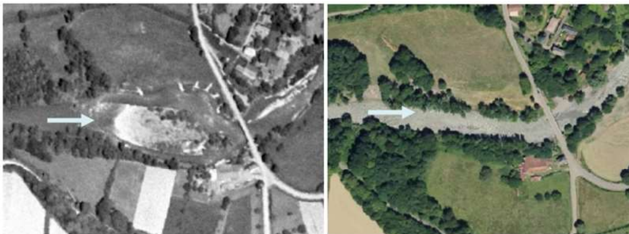
FIGURE 168 : SUPPRESSION DU SEUIL EN AMONT DU PONT D'ANÈRES (ARTELIA, 2016)
