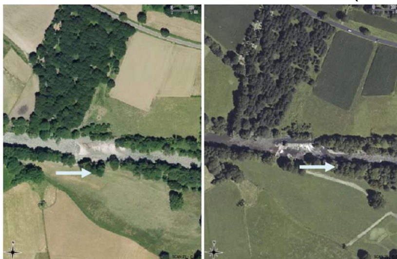
FIGURE 169 : DESTRUCTION DU SEUIL BALMELLE / ARTIGAUX SUITE À LA CRUE DE 2013
