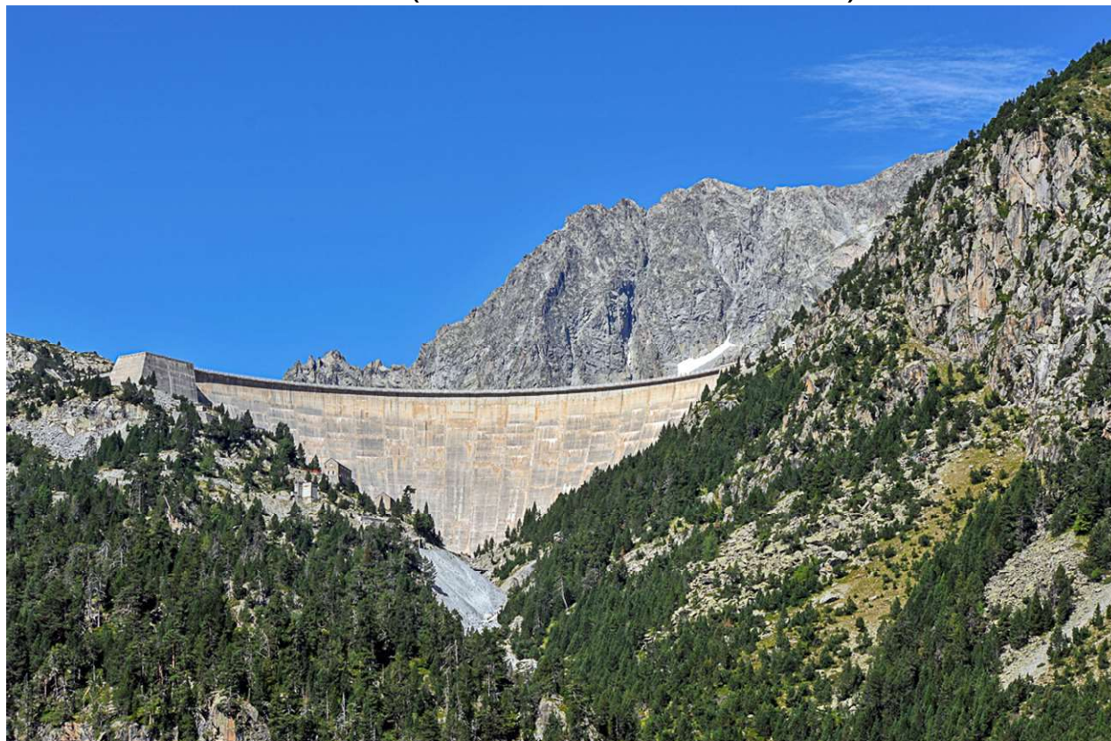
FIGURE 119 : BARRAGE DU CAP DE LONG (SOURCE : PATRIMOINE-AURE-LOURON.FR)
