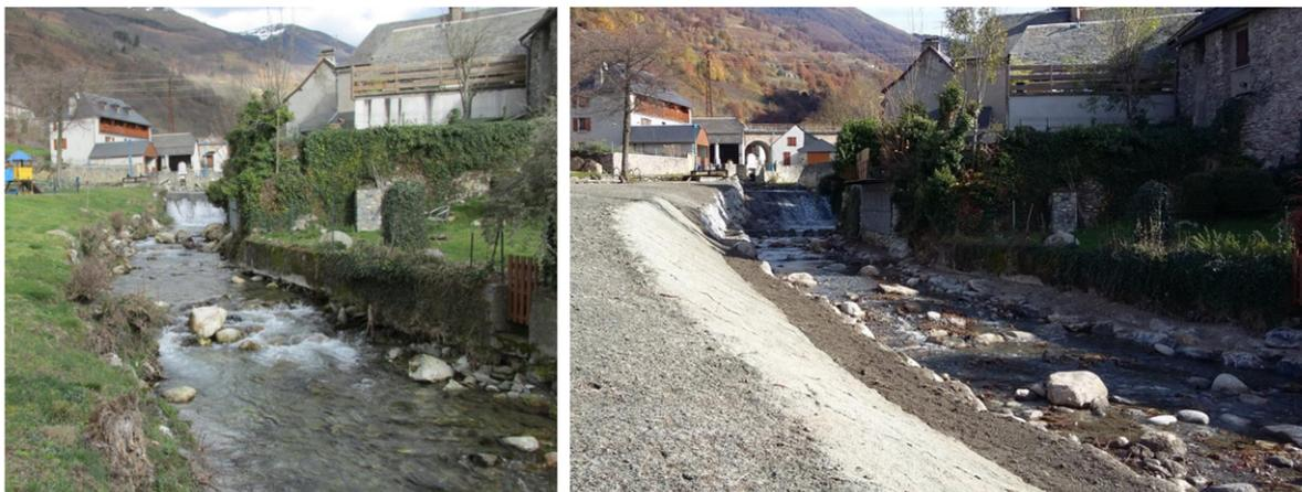
5 ans après la réalisation de cette prestation, les résultats s'avèrent ne pas être suffisamment satisfaisants : des affouillements ont été observés, le cours d'eau est serré dans le cône de déjection, la crête du seuil n'est pas adaptée. Ainsi, une réflexion se porte sur cette action, qui n'a pas permis de résoudre les problèmes identifiés initialement.
