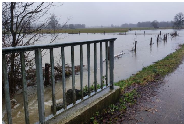
Crue du Merdan en 2022 vue du ponton de début de parcours
