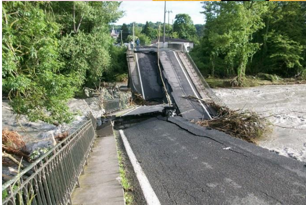
Pont effondré de Saint-Laurent-de-Neste en 2013
